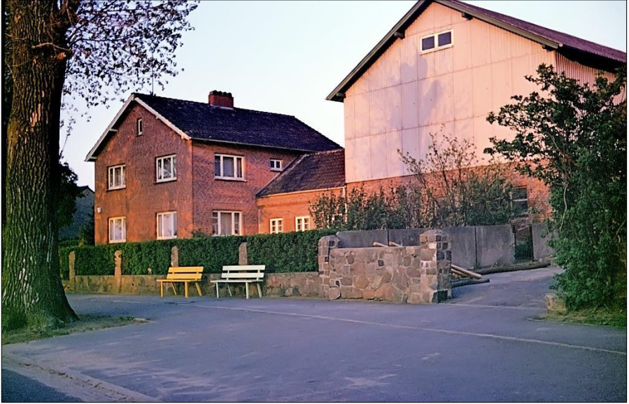
Wohn- und Wirtschaftsgebäude
