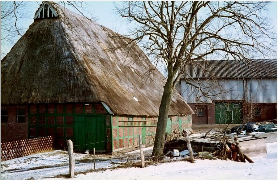
Alte Scheune in den 1960-er Jahren
