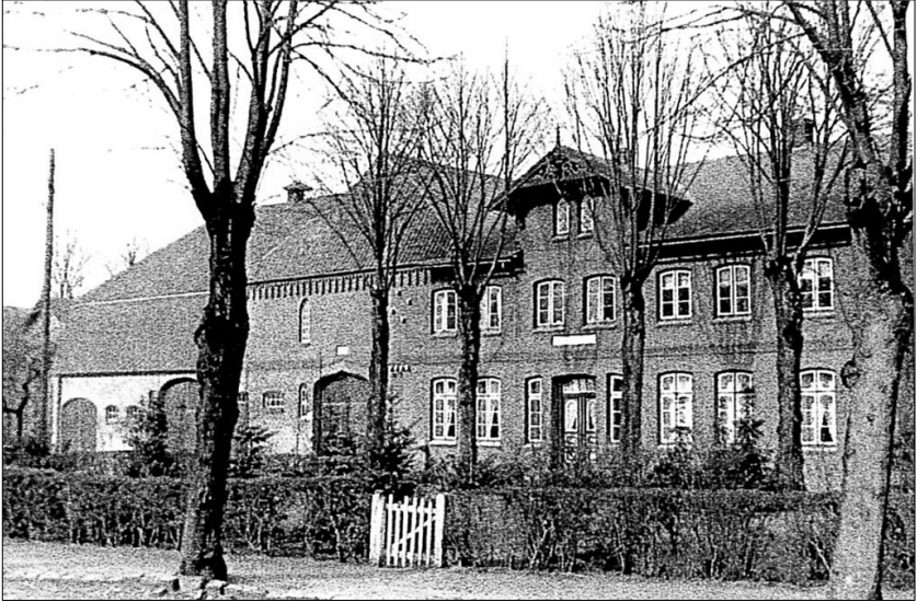
Die alte Hofanlage
