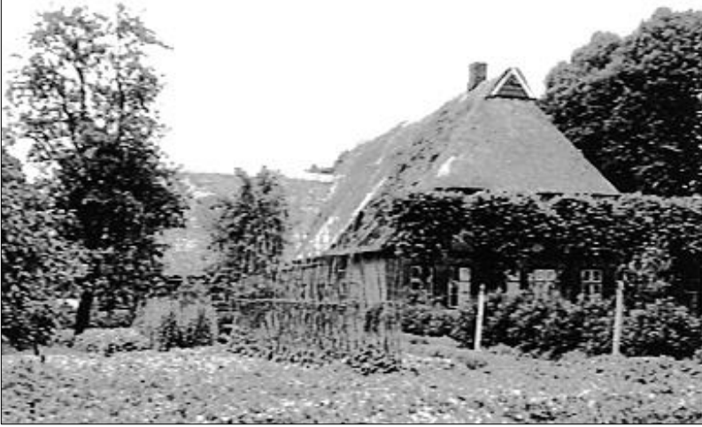
Das 1871 errichtete strohgedeckte Wohn- und Wirtschaftsgebäude der Hufe (Foto: Archiv Claus Reese)
