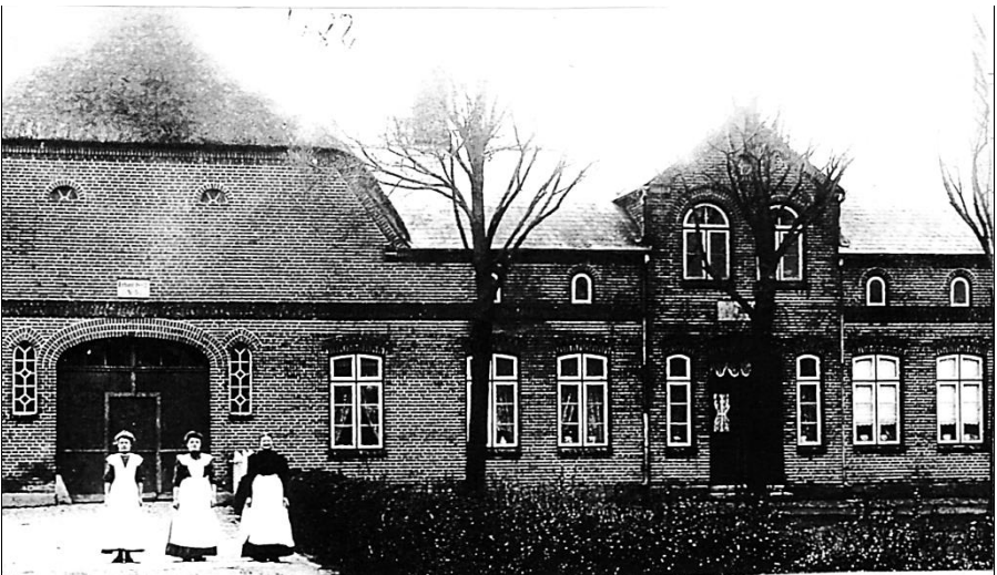
Wohn- und Wirtschaftsgebäude der Hufe
