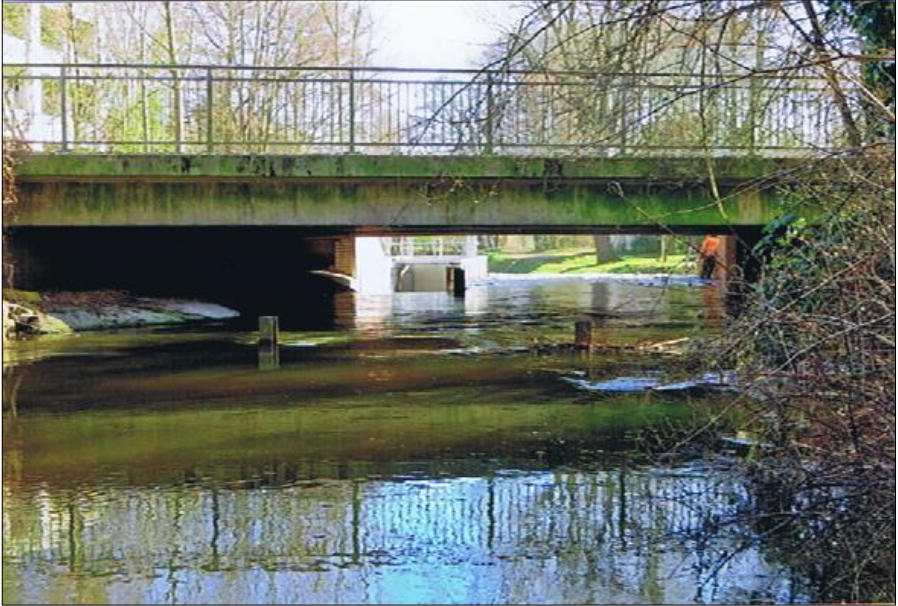
Die Brücke an der Klosterstraße von Westen
