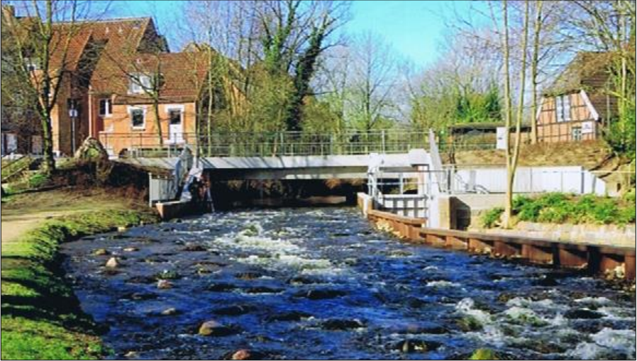
Wiederherstellung der Durchgängigkeit der Alten Schwentine an der ehemaligen Klostermühle Preetz
