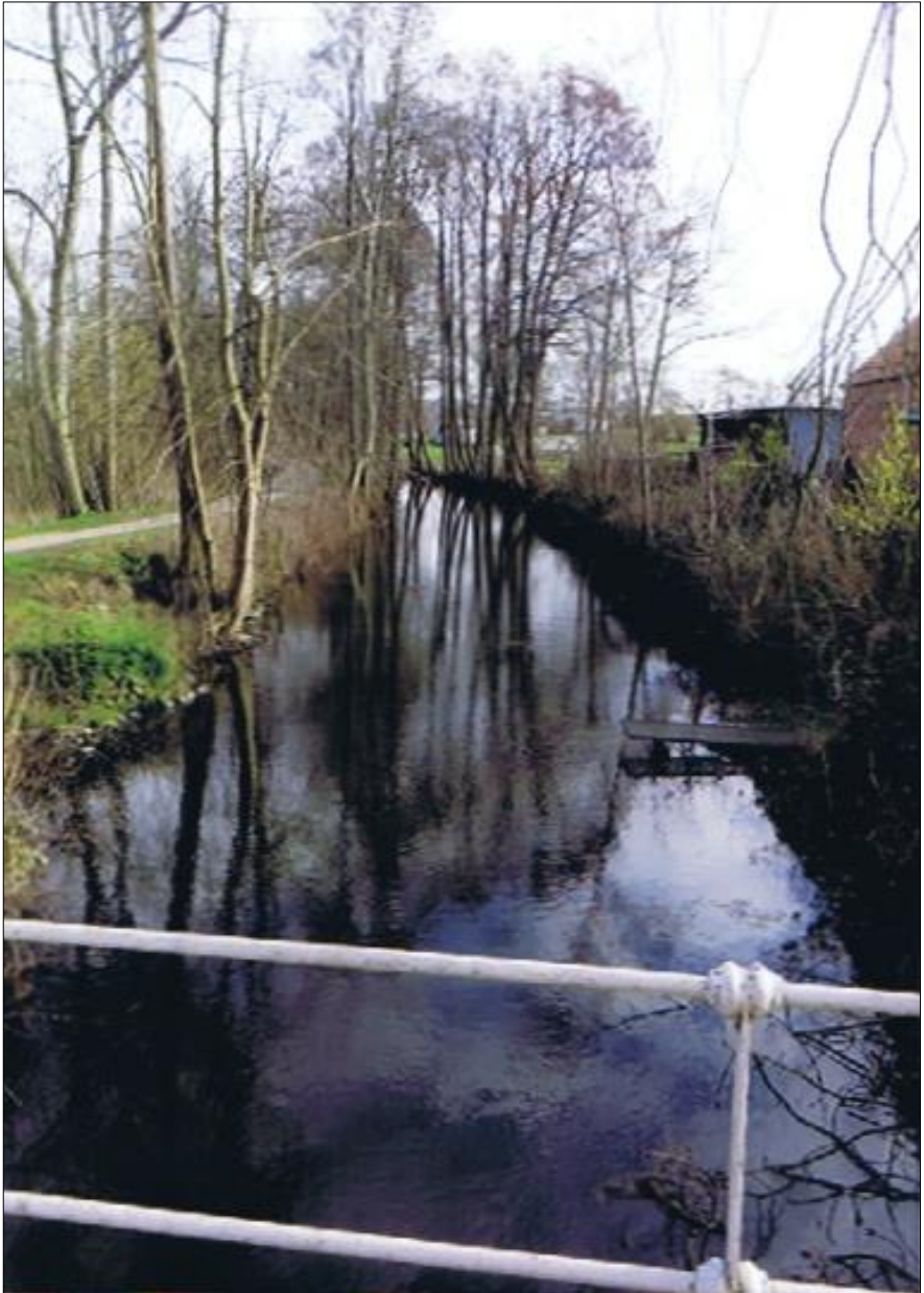
Flusslauf am Gebäude der Perdoeler Mühle 244
