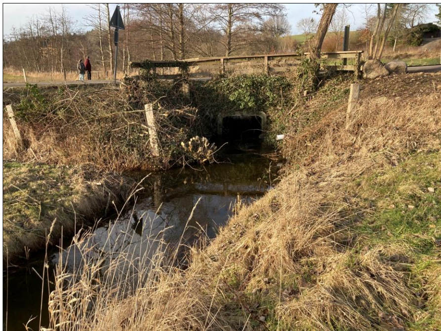
Abb. 9: So sieht die Stelle des Damms bzw. Siels, durch das der Knüppeldammsgraben gestaut wurde, heute aus. Natürlich war der Damm einige Meter höher. Genau an dieser Stelle muss auch die Wassermühle ihre Mahlarbeit verrichtet haben. In Blickrichtung nach ca. 200 m fließt auch noch heute der Knüppeldammsgraben in den Schierensee.
