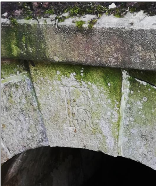
Abb. 16: Mittlerer Bogenstein der Rotenhahner Brücke (Foto: Jürgen Lehmann)
