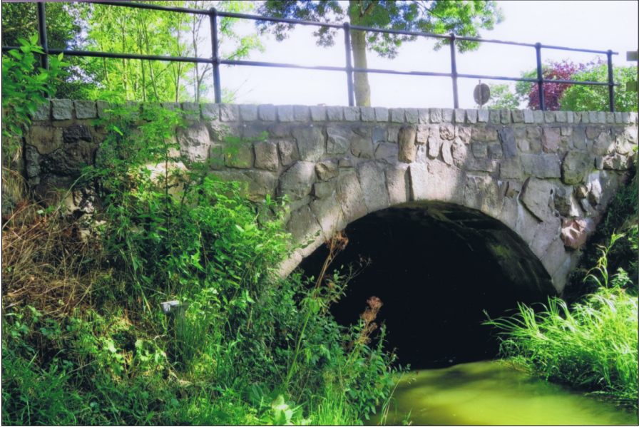
Die Eiderbrücke in der Dorfstraße von 1792
