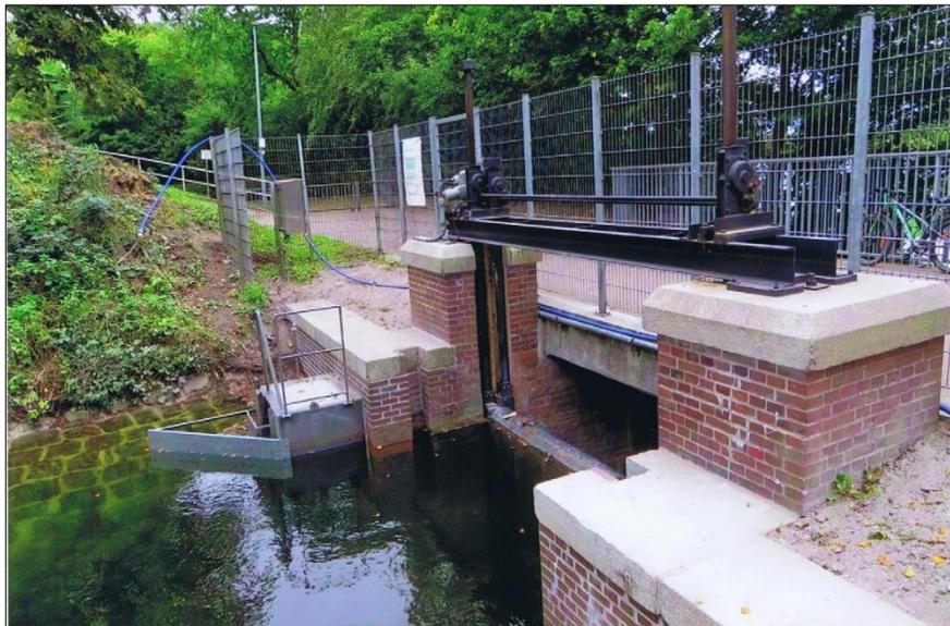
*Durch ein Nadelwehr östlich der Schleuse wird bei Bedarf in den NOK entwässert.*
