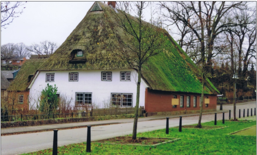
Ein Foto aus 2018, das Gebäude ist zum Teil saniert, aber an der Straßenseite sind bereits die Fenster zum Saal verbrettert. Der Abriss soll erfolgen. (Beide Fotos: Rolf Pohlmeier)
