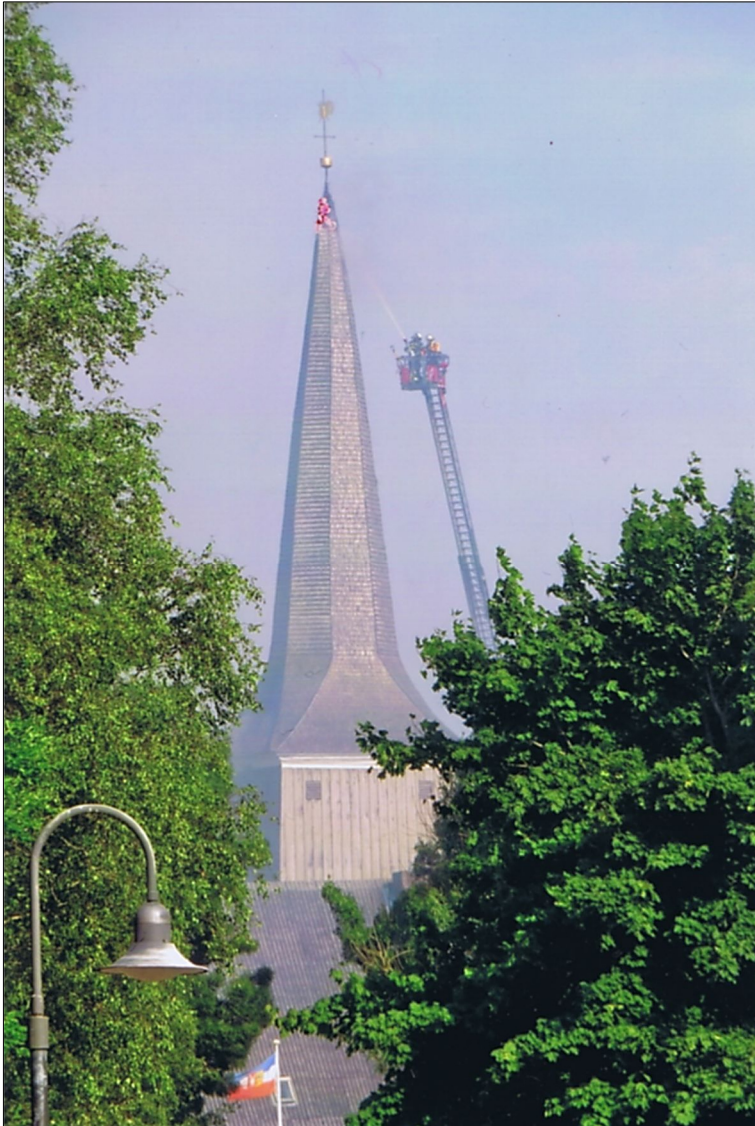
Der Kirchturm hat Feuer gefangen. Gegen 18.00 Uhr schlugen Flammen aus der Turmspitze. Der Turm ist von Rauch umhüllt. Die Feuerwehrleute auf der Drehleiter bewässern den gesamten Turm mit Eiderwasser. Das war die Rettung, die Situation war brenzlich. (Foto: Rolf Pohlmeier)
