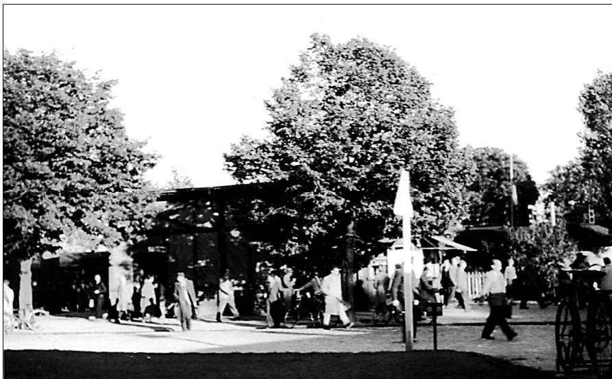
Die alte Wartehalle
